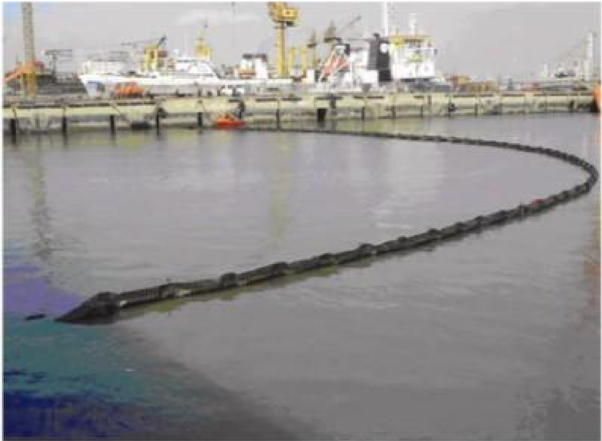
图5 港口码头围油栏的布控
