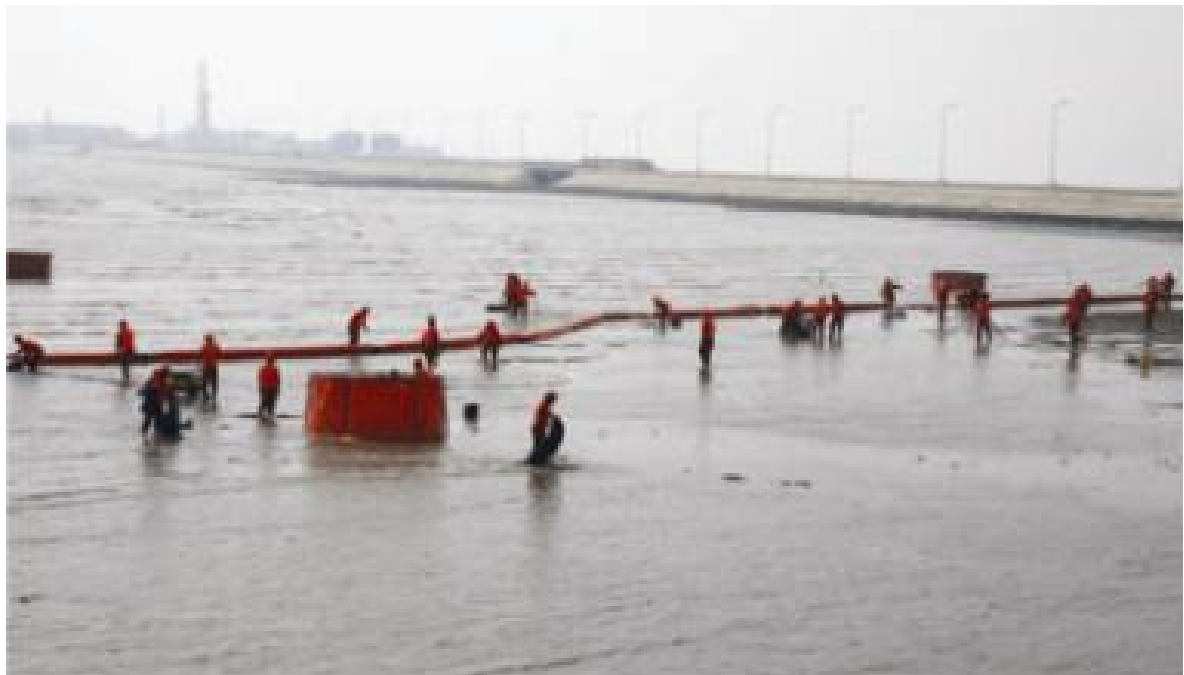
图 13 岸滩围油栏的布放方式二
