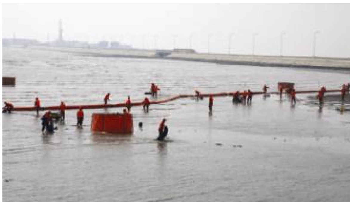
图 13 岸滩围油栏的布放方式二
